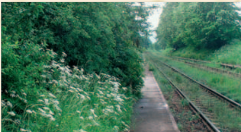
Trať před rekonstrukcí
